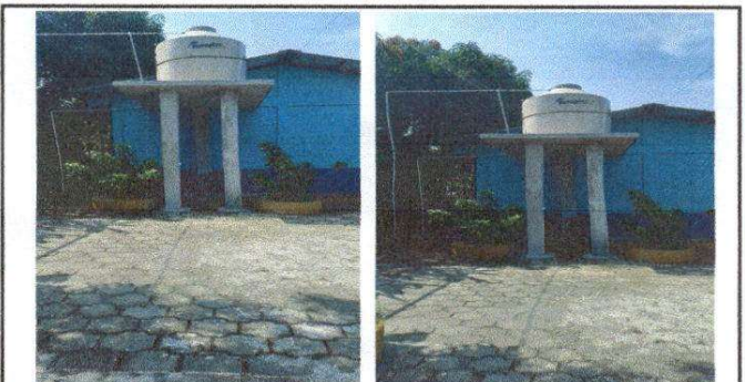
Foto 6: Sustitución de accesorios, depósito de agua
