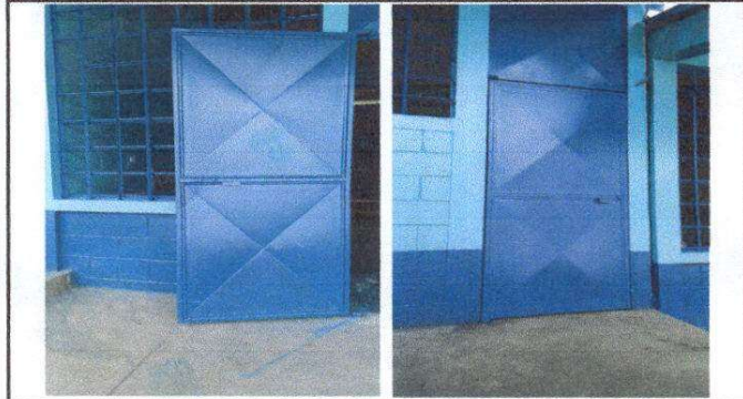
Foto 1: Mantenimiento de puertas de metal, aulas.
