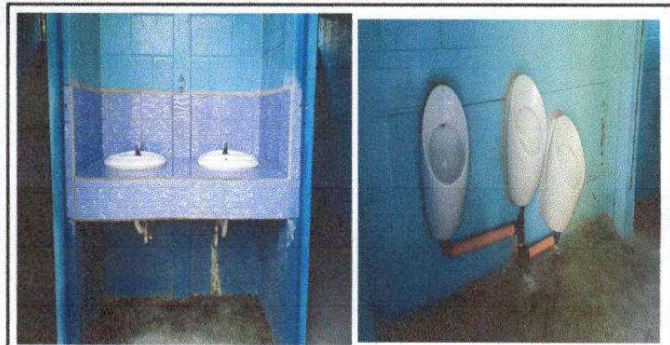
foto 5: Sustitución de lavamanos y mingitorios
